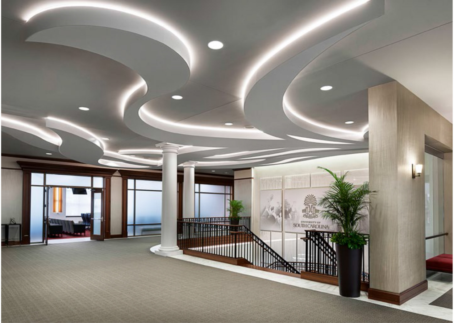
Université de Caroline du Sud - ETATS-LUNIS - Plafond acoustique Architecte : L3SP - Installation : Warco Constructions Inc.
